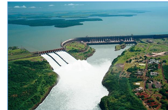
ГЭС Итайпу Бразилия / Парагвай 14000 МВт (1984 г.)
